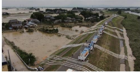
排水ポンプ車の排水状況事例
