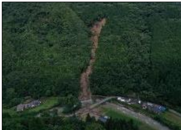
緊急に復旧すべき山腹崩壊箇所
