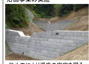
谷止工により溪床の安定を図る
