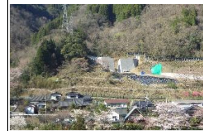
保全対象直上に砂防堰堤を整備
