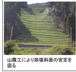
山腹工により崩壊斜面の安定を図る
