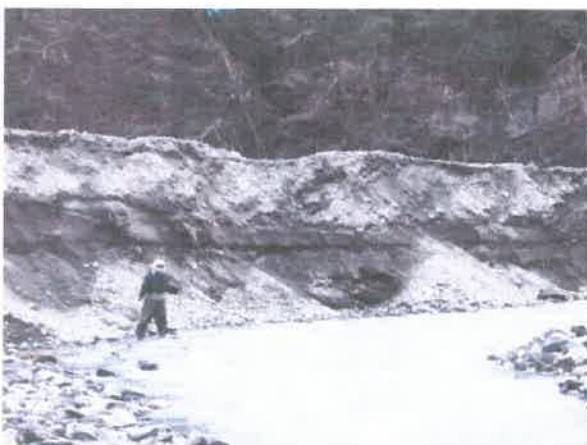
←朴ノ木ダム上流に大量に堆砂した土砂(2006年1月)
