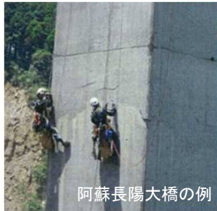
阿蘇長陽大橋の例 ロープアクセスによる調査の例
