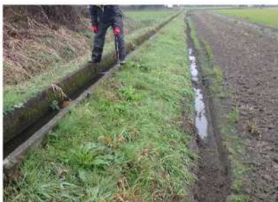
漏水対策 (ほ場内に漏水受け土水路)
