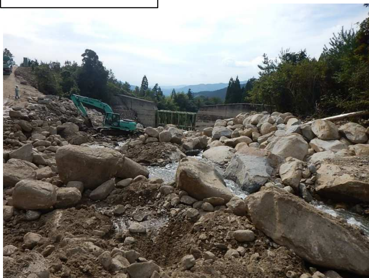
土砂撤去状況
