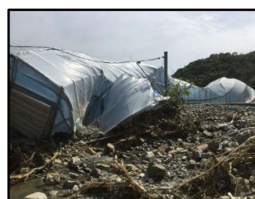
ハウスの倒壊・土砂流入(芦北町田浦)
