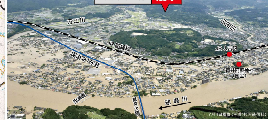
人吉市中心部 浸水
