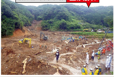
福浜地区(津奈木町) 土砂崩れ
