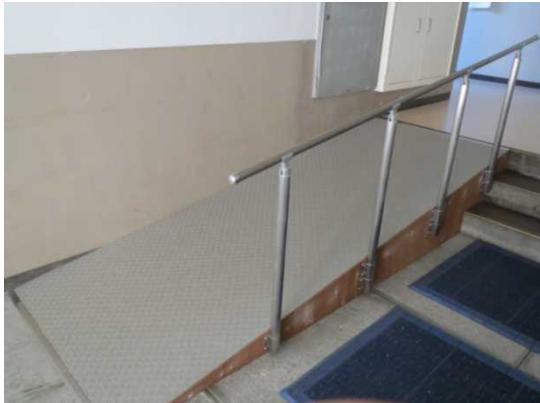
スロープ・手すり
