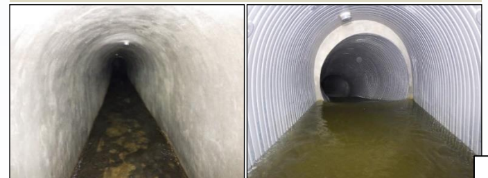
旧取水トンネル復旧(完了)
