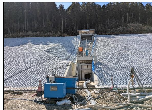
取水設備・操作室(完了)
