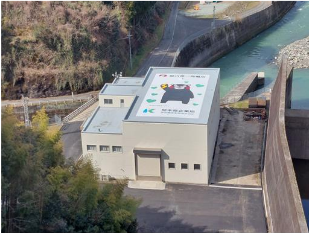
緑川第一発電所（下益城郡美里町）
