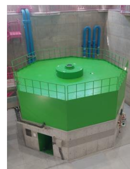
第一発電所発電機（リニューアル後）
