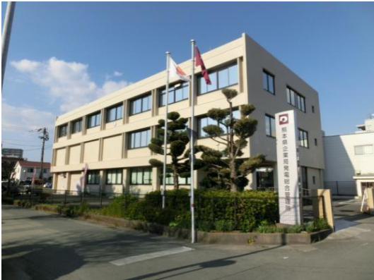
発電総合管理所全景
