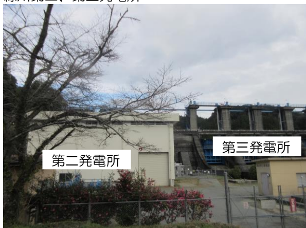
緑川第二、第三発電所
