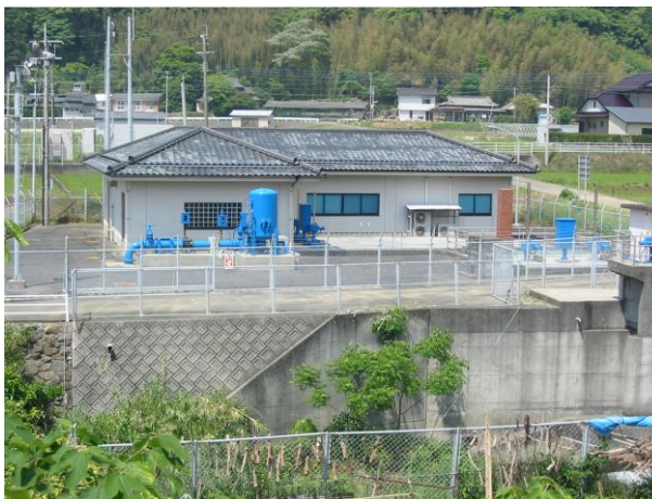
中の田ポンプ場
