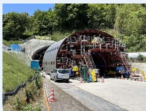
熊本天草幹線道路 （仮称）大矢野トンネル（上天草市）
