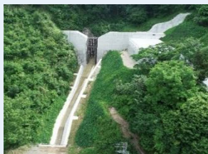
久原川砂防堰堤（山鹿市）
