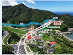
国道389号下田南BP（天草市）
