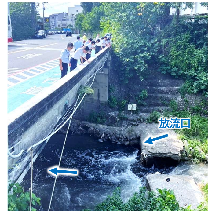
処理場放流先河川(新竹SP)確認状況 20
