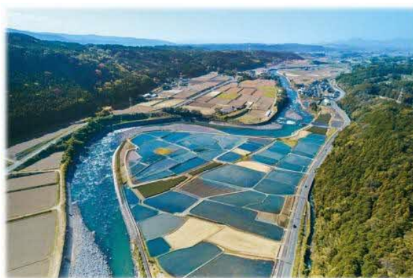
図3 大津町瀬田地区の冬期湛水の様子
