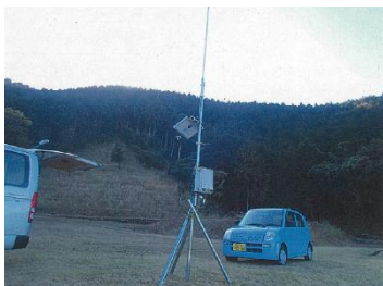
ICT 機器（中継機）の設置
