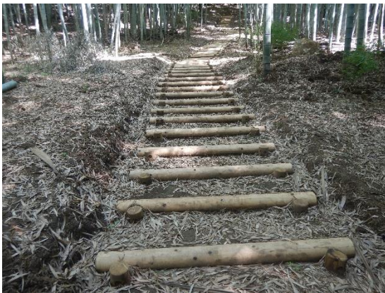
木製階段の設置
