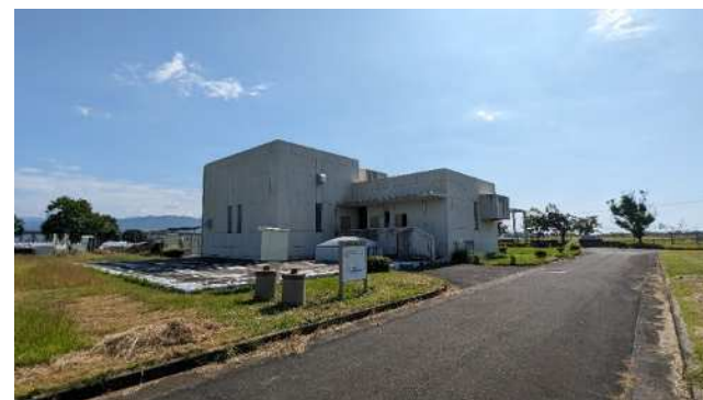
沈砂池・ポンプ棟
