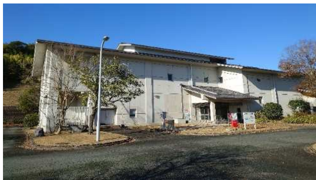
沈砂池・ポンプ棟
