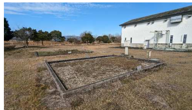
汚泥脱臭床 (汚泥処理棟横)
