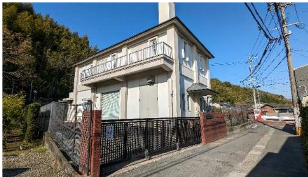
弓削汚水中継ポンプ場
