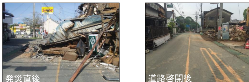
図 1-1 熊本地震時の道路啓開記録（益城地域）
