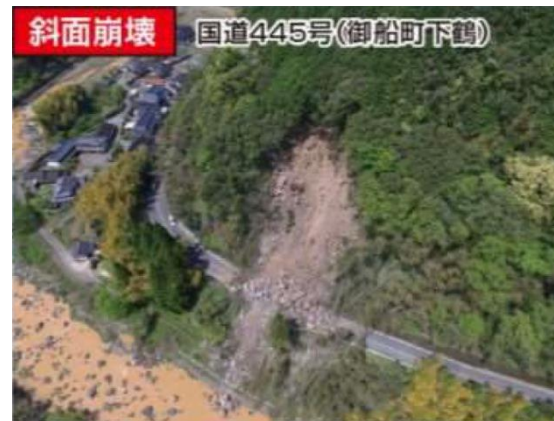
図 3-22 道路の被災リスク（法面崩壊：平成 28 年熊本地震による被害）
