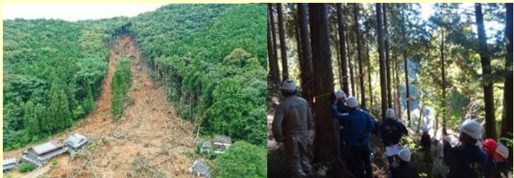
R2年7月豪雨被災状況
