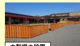
木製塀の設置
