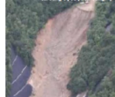
廃棄された土石の崩落
