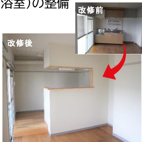
県営住宅の改修事例 (対面キッチン)
