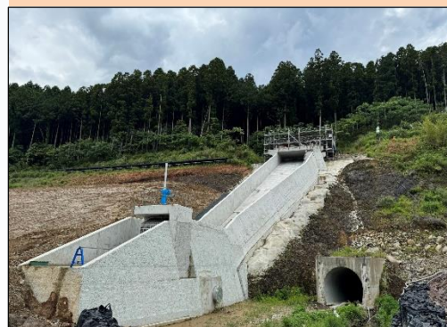
取水設備・操作室
