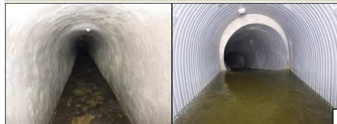
旧取水トンネル復旧(完了)
