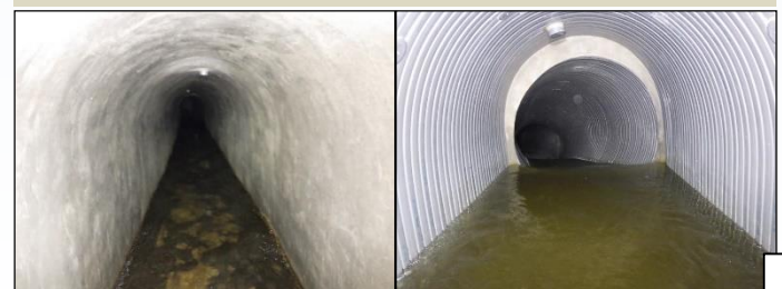
旧取水トンネル復旧(完了)
