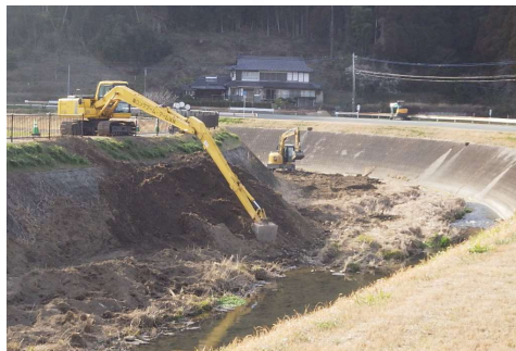
河道掘削イメージ
