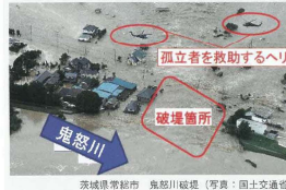
茨城県常総市 鬼怒川氾濫（写真：国土交通省）
