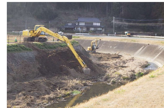
河道掘削イメージ
