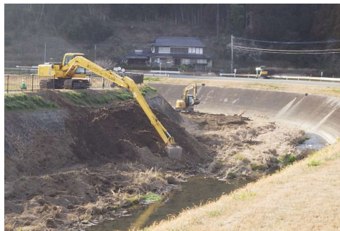
河道掘削イメージ
