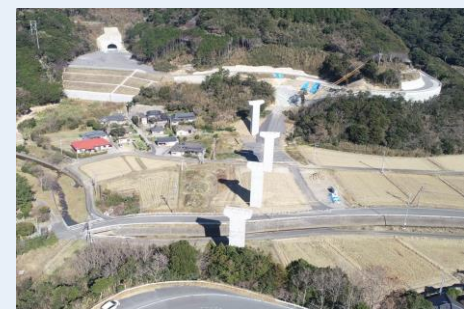
国道389号下田南BP(天草市)
