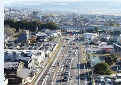
4車線化整備箇所（広崎地区）
