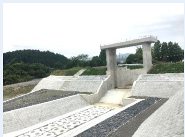
【河川】御溝川二次放水路整備(人吉市)
