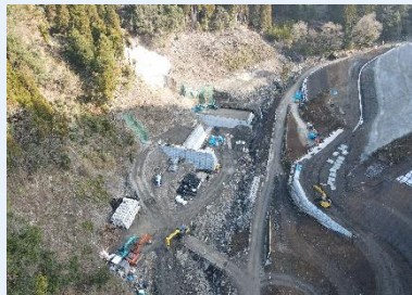
【砂防】川内川砂防堰堤整備(球磨村)
