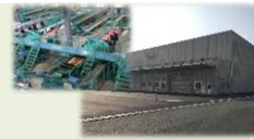
集出荷施設の整備
