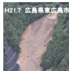
廃棄された土石の崩落
