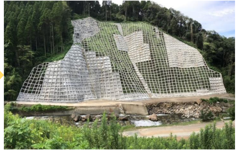
復旧状況（山腹工）
