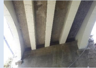
【橋りょう】モダン橋(阿蘇市)の補修
