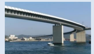
【漁港】牛深ハイヤ大橋橋梁の補修
