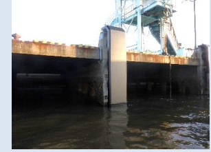
【港湾】熊本港(熊本市)大型防舷材補修
