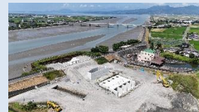
【農地】竜北排水機場(八代郡水川町)
