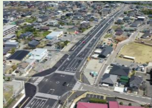
益城中央線(益城町)の整備
