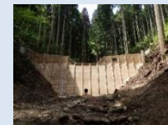
【森林】治山ダムの設置
