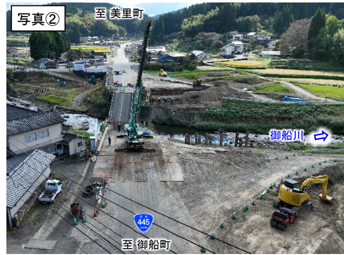
▲ 仮橋下部工の基礎杭施工中
