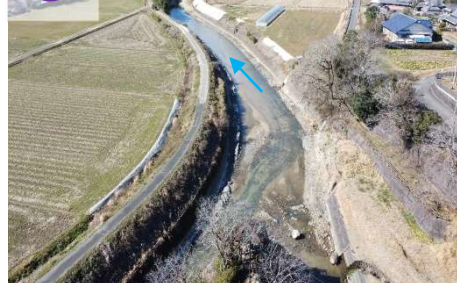
③ 河床掘削工 R5.3完了
