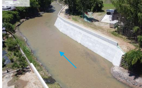
② 引堤工 R5.6完了
