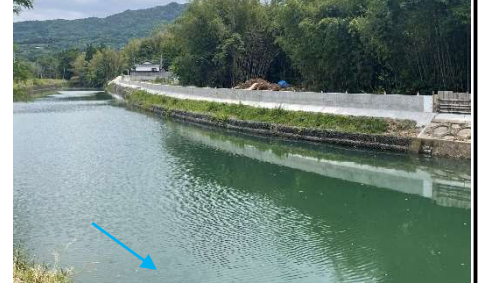
④ 浸水対策工 R5.10完了
