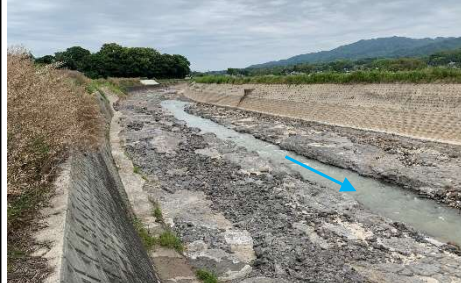
① 河床掘削工 R5.3完了
