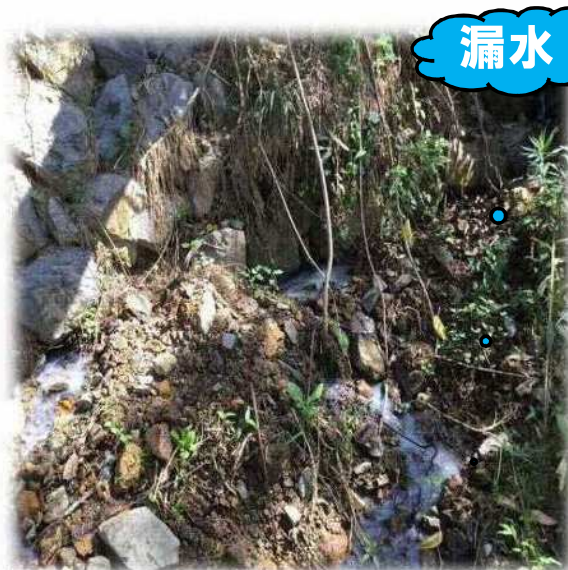
堤体の法尻からの漏水
