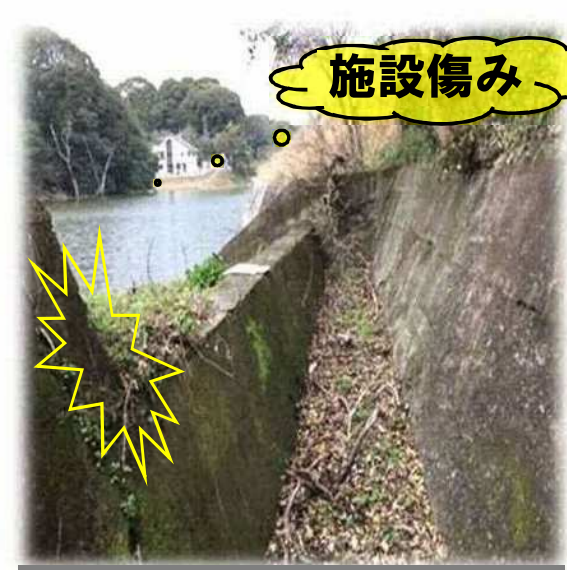
洪水吐取付部のひび割れ
