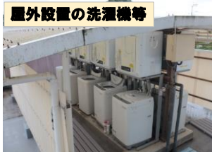
屋外設置の洗濯機等
