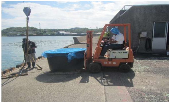
フォークリフトによる水槽の移送作業
