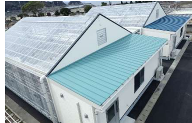
海藻研究棟の整備
