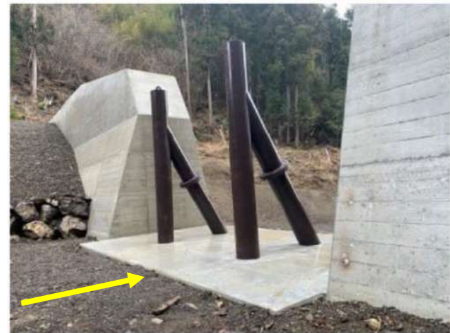
鋼製スリット堰堤 A 型
