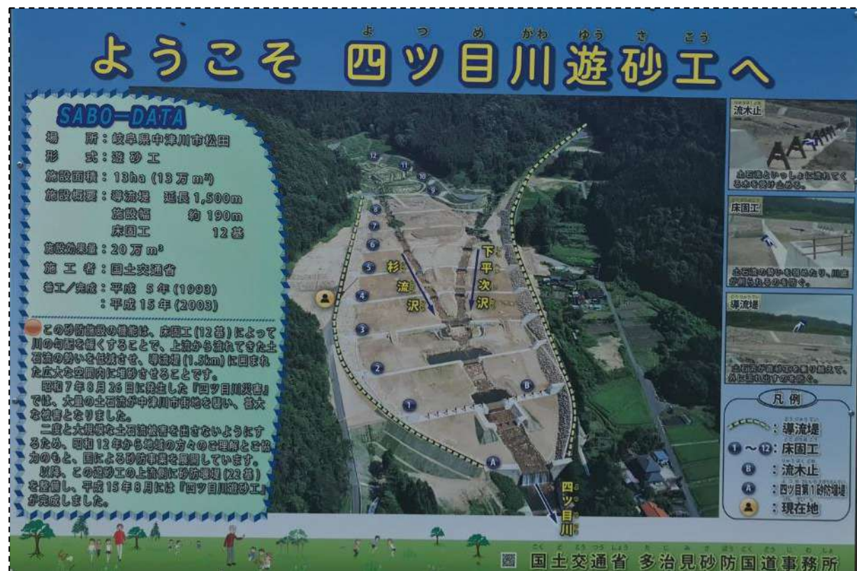
図 3-7 遊砂地工の事例（岐阜県・四ツ目川遊砂地工）
