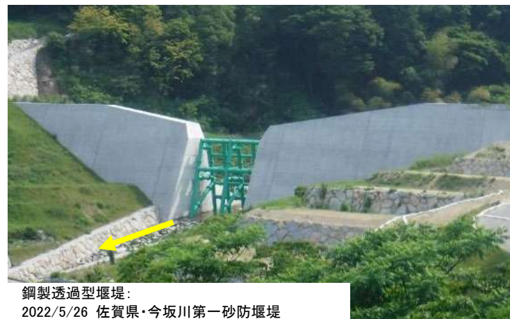
図 3-1 透過型砂防堰堤のイメージ（他地域での事例）
