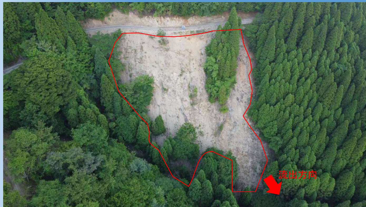
林道より下方の急斜面で山腹崩壊が発生、2021年6月9日撮影
