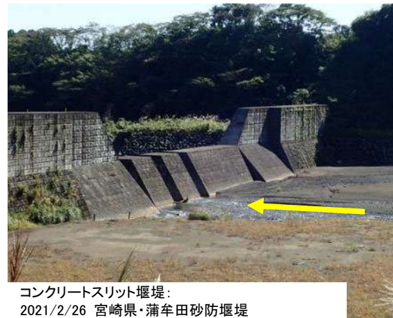
図 3-1 透過型砂防堰堤のイメージ（他地域での事例）
