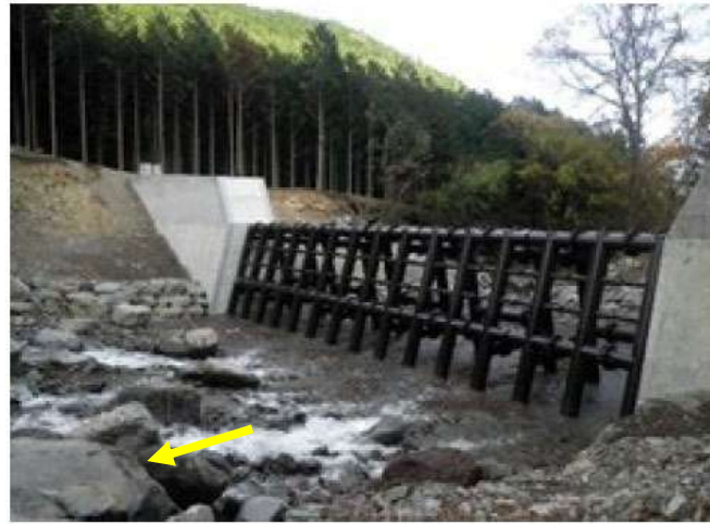
鋼製スリット堰堤 B 型
