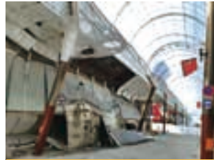
健軍商店街における商業施設の復旧状況
