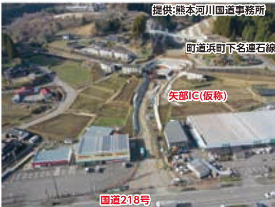
九州中央自動車道 矢部IC(仮称)
