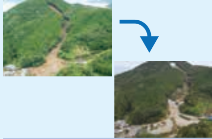
大坪川（津奈木町）復旧状況
