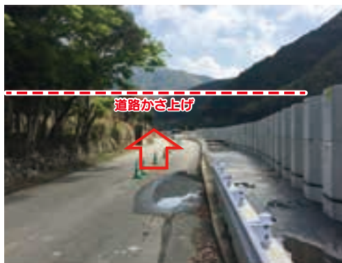
国道219号の復旧状況
