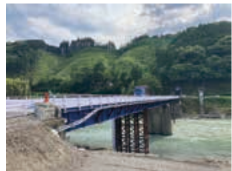
仮橋の設置状況(相良橋)
