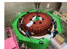
緑川第一発電所 回転子つり込み作業
