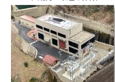
市房第一発電所
