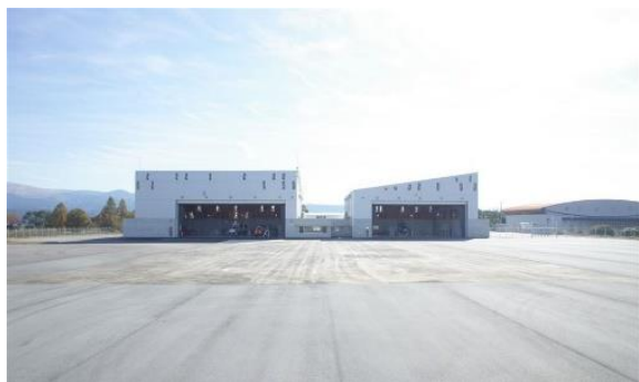
総合防災航空センター
