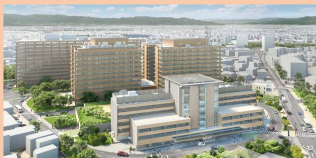
【新防災センター完成図】
