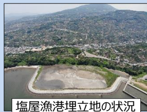
塩屋漁港埋立地の状況
