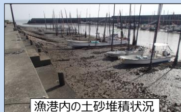
漁港内の土砂堆積状況
