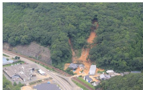
芦北町湯治（国道、鉄道沿線の山腹崩壊）
