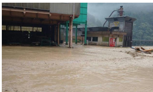
球磨村森林組合製材工場（濁流流入状況）
