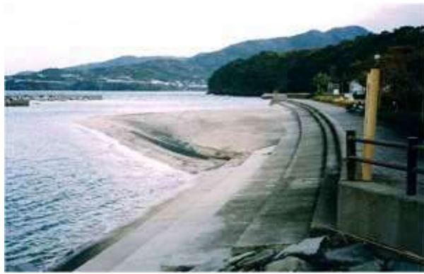
緩傾斜護岸(湯の児海岸)
