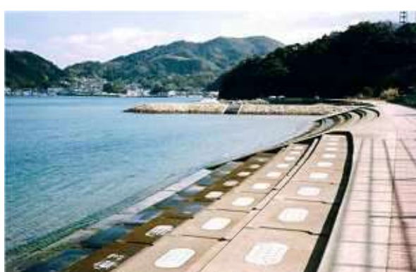
緩傾斜護岸(上天草港海岸)
