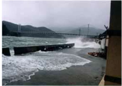
越波による被害(上天草市龍ヶ岳町)
