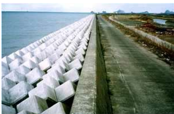
堤防(消波工)(金剛海岸)
