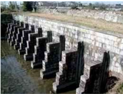
旧郡築新地甲号樋門(八代市)
