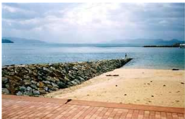
突堤、養浜(中形浦海岸)
