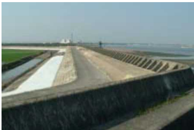
写真 1.14 川副海岸（佐賀県佐賀市川副町）
