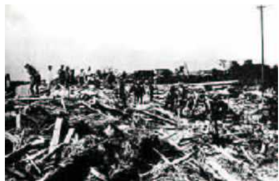
写真 1.4 高潮被害状況 (熊本県熊本市沖新)
