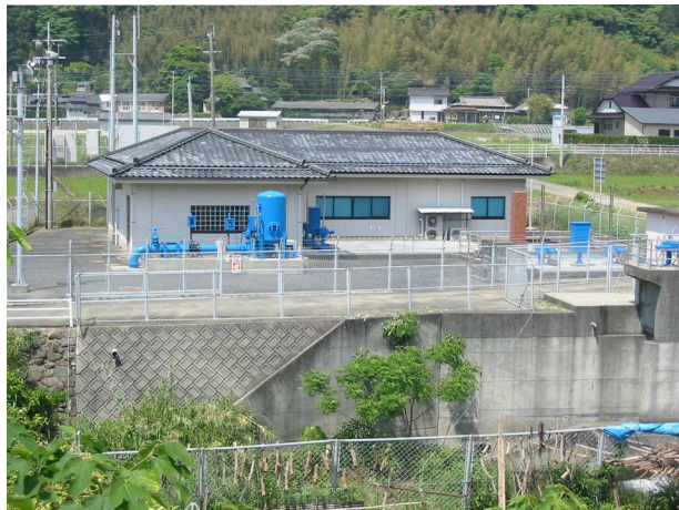
中の田ポンプ場
