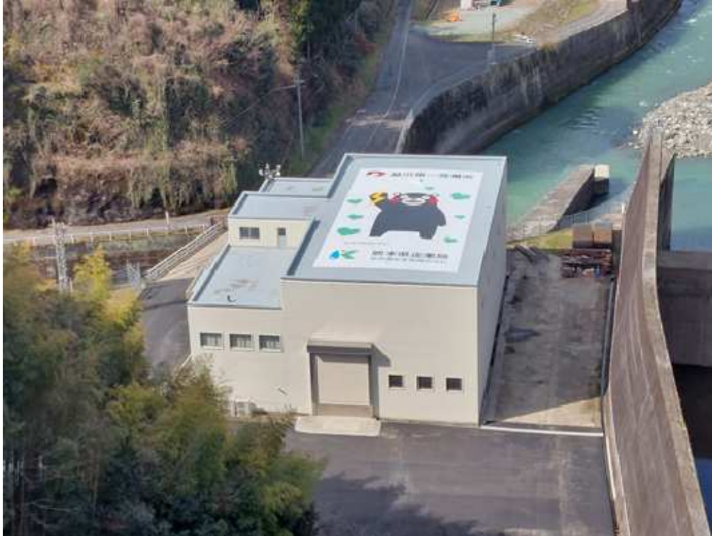
緑川第一発電所（下益城郡美里町）
