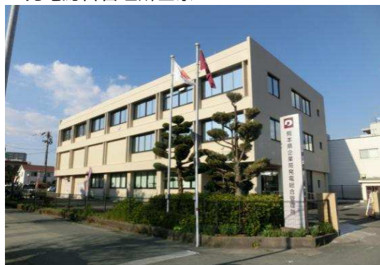
発電総合管理所全景
