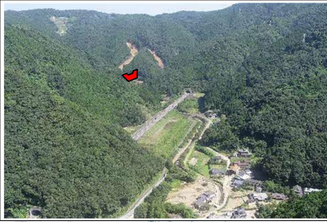
⑥ 乙千屋川 (芦北町乙千屋) 砂防えん堤
