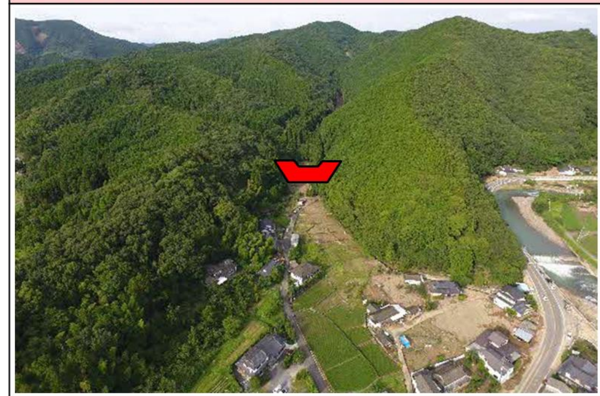
② 園口川 (芦北町八幡) 砂防えん堤
