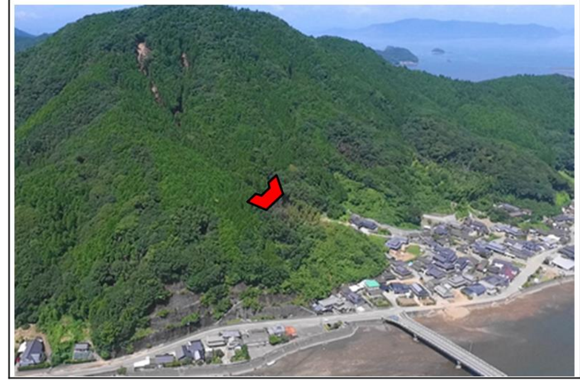
④ 上平生川-1 (芦北町女島) 砂防えん堤
