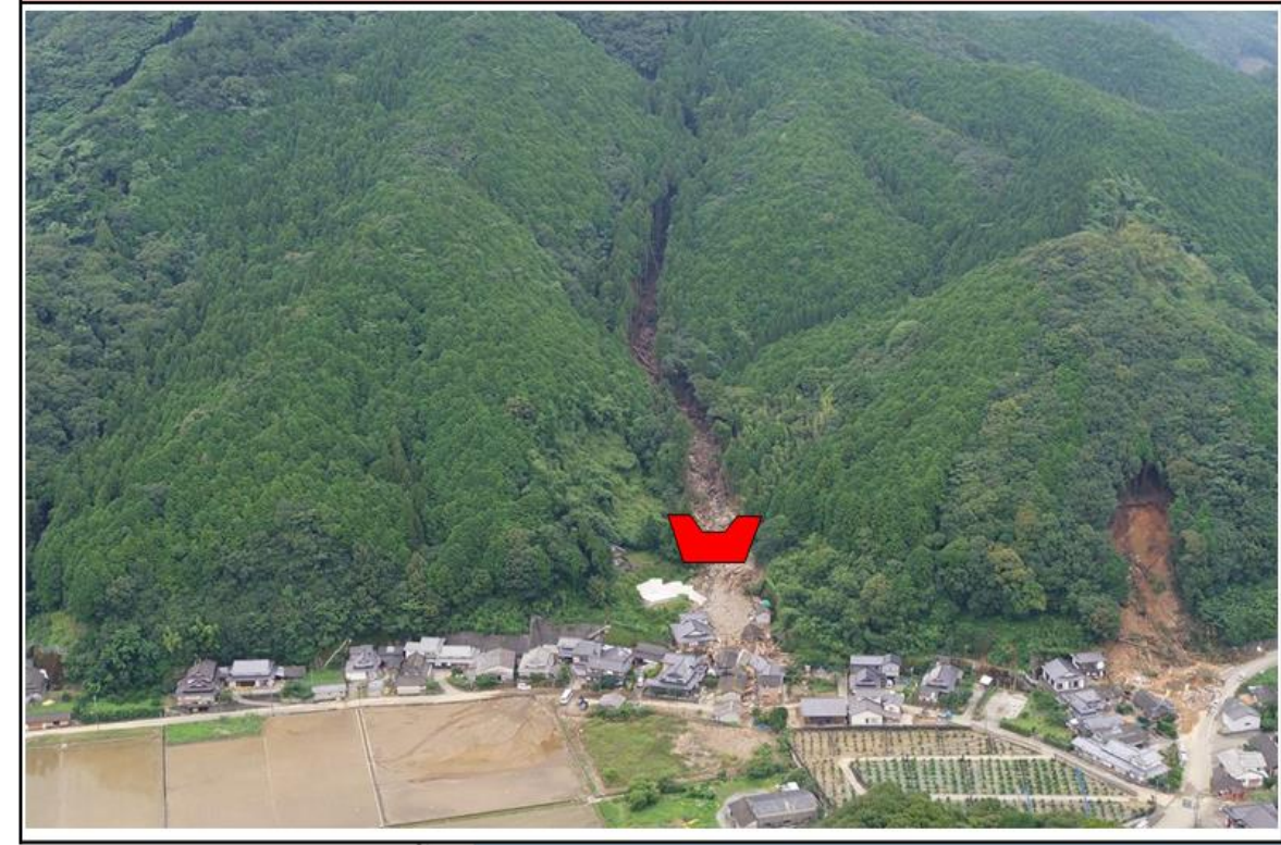
③ 小崎川 (芦北町女島) 砂防えん堤
