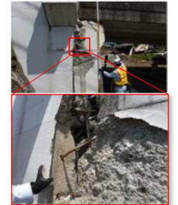
ウイング部の大規模損傷
