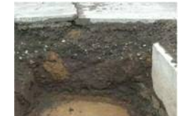
掘削調査状況
