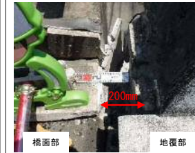
上部工の橋軸方向のずれ
