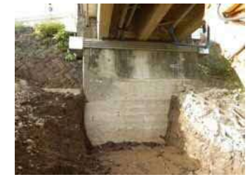
掘削調査状況
