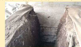
▲写真 掘削調査状況
