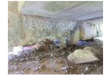
主桁欠損
