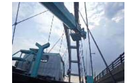
ケーブル調査状況
