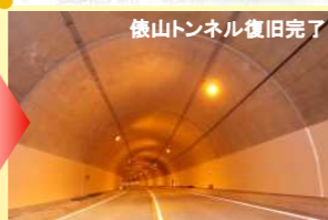
俵山トンネル復旧完了
