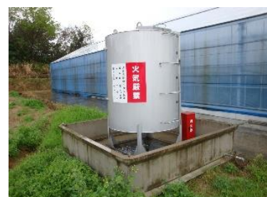
防油堤の設置
