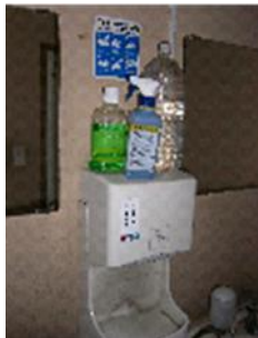
手洗い場の設置
