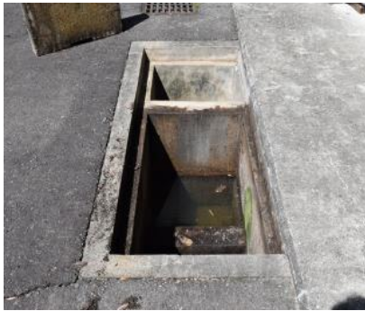
排水設備の設置
