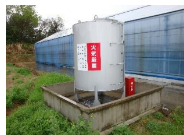
防油堤の設置
