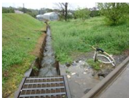
水路やバルブの確認
