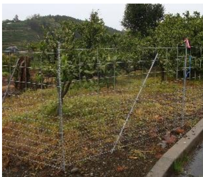
侵入防止柵の設置
