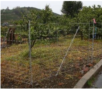
侵入防止柵の設置
