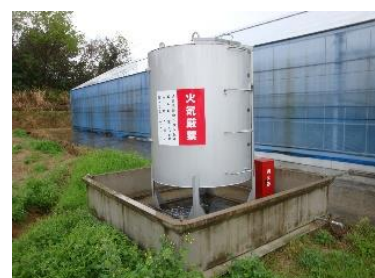
防油堤の設置
