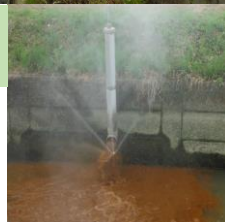
防除用動噴を用いての暗渠洗浄の様子
