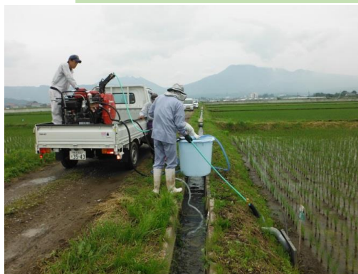
防除用動噴を用いての暗渠洗浄の様子
