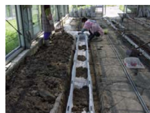
③ 遮根シートの内側に培地を入れる
