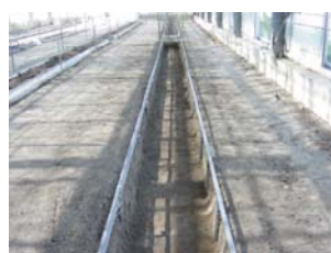
① 管理機等で溝を掘り直管パイプで枠を作る
