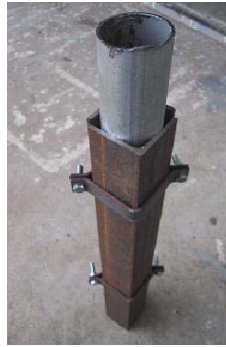
写真2 アングル鋼による谷樋支柱補強
